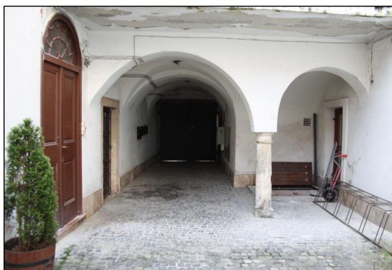
17. ábra: A Kazinczy udvar északkeleti átjárója
